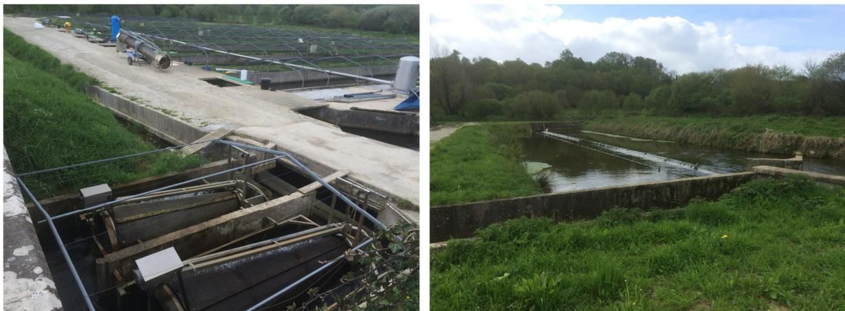
*Figure 2-5 : Défeuilleur en entrée de pisciculture – Bassin décanteur en sortie de pisciculture*
